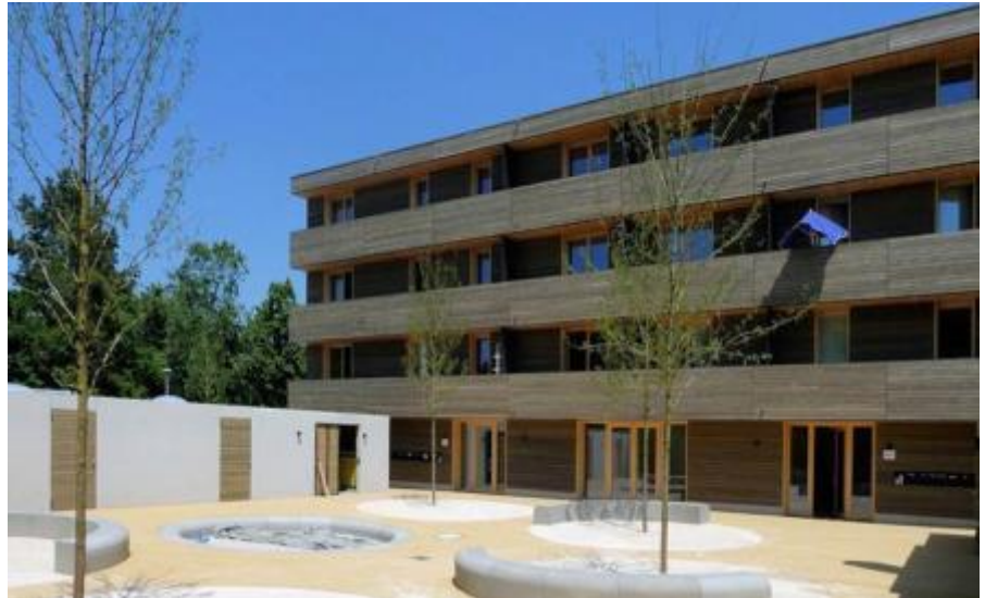
Ansicht des viergeschossigen Holzbaus mit Innenhof im Vordergrund (Foto: Matthias Jakob, Joseph-Stiftung, Kirchliches Wohnungsunternehmen, Bamberg)
