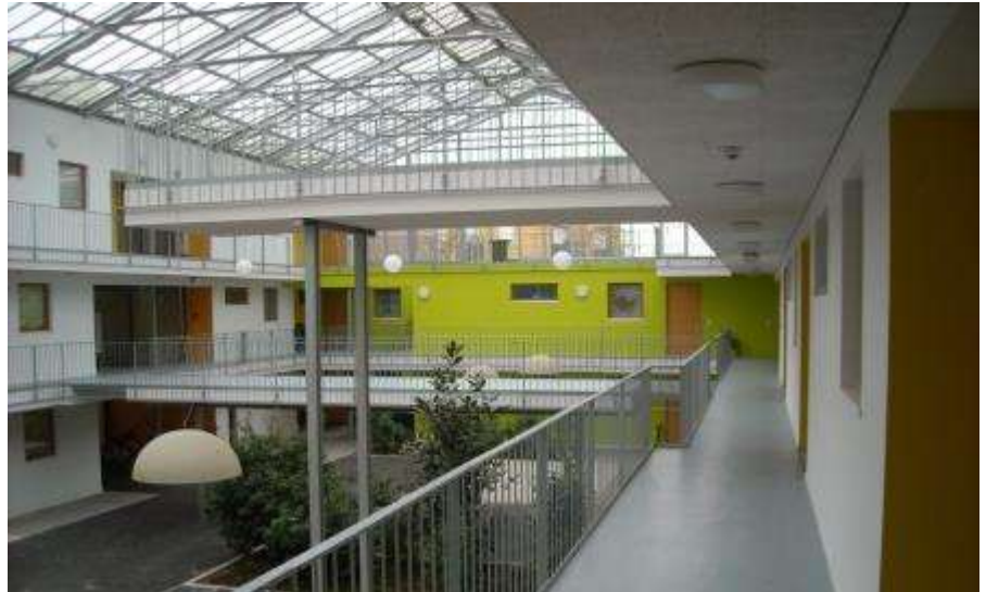
Atrium mit Erschließungsstegen im Bauteil II (Foto: Philipp Vohlidka, Lehrstuhl für Bauklimatik und Haustechnik, Technische Universität München)
