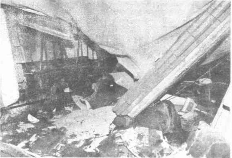
Bild 1: Eingestürzte Viehstaldecke
