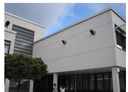
Zustand vor Sanierung (Foto STBA)
