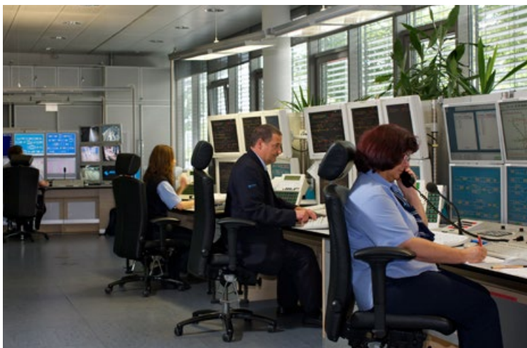
Besetzte Betriebsleitstelle der U-Bahn München Quelle: SWM/MVG
