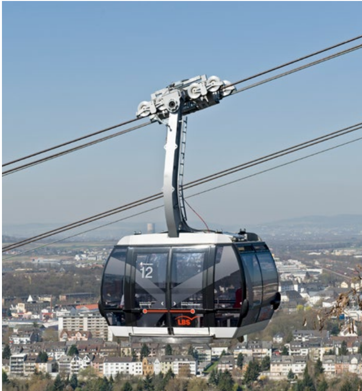
Koblenzer Buga-Seilbahn Dreiseil-Umlaufbahn Quelle Doppelmayr
