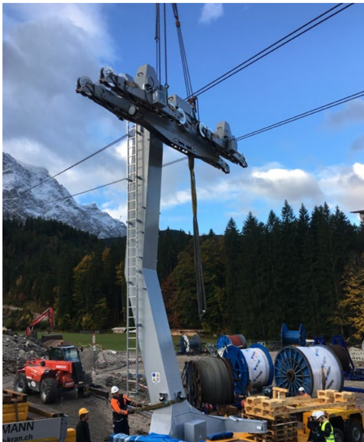
Einhängen eines Fahrwerks in Tragseile Quelle: StMB
