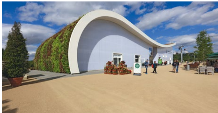
Ökologisch hochwertig geplante Talstation in Berlin Quelle: Leitner
